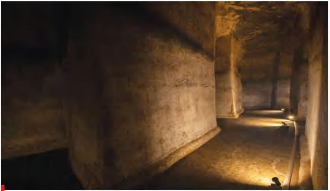
Ponza sotterranea: la cisterna romana della Dragonara. Nella pagina a fianco: meraviglioso tramonto sul mare ©Odissey Diving.
